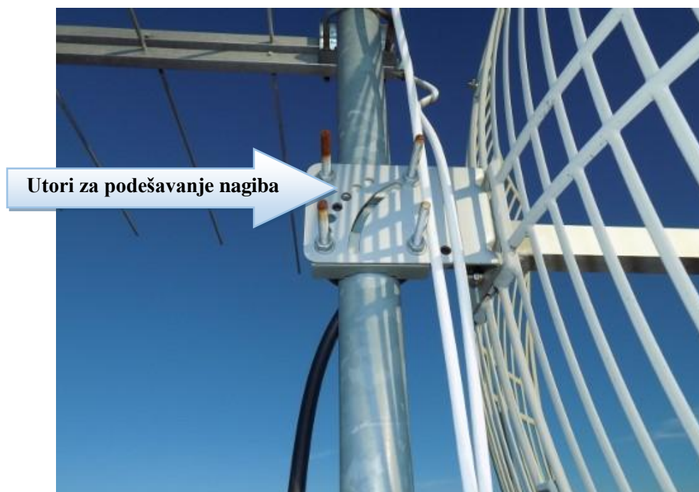
2.3. - Druga strana nosača sa utorima za vertikalno podešavanje
